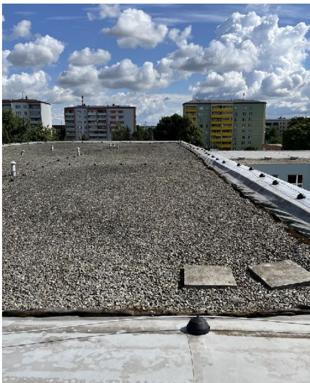
Obrázek 3 - Střešní konstrukce z PVC krytinou a kačirkem
