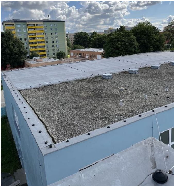
Obrázek 5 - Větrací komínky a vpust
